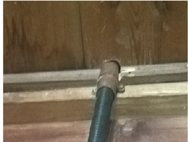
ნახ. 13. იზოლირებული მეტალის გოფრირებული მილის გატარება ფიცრის ნახვრეტში.
