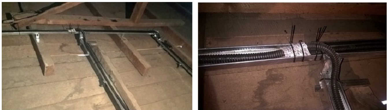
ნახ. 12. მღრღნელებისაგან დამცავი ცეცხლგამძლე ფირფიტების გამოყენება კაბელებისა და მილების განშტოების ადგილებში
