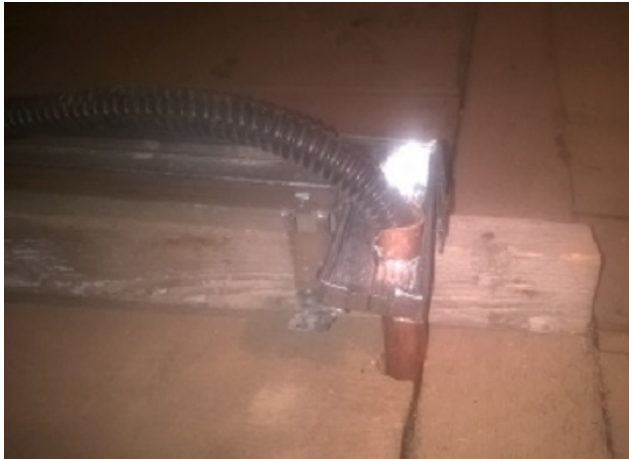
ნახ. 13. იზოლირებული მეტალის გოფრირებული მილის გატარება ფიცრის ნახვრეტში.
